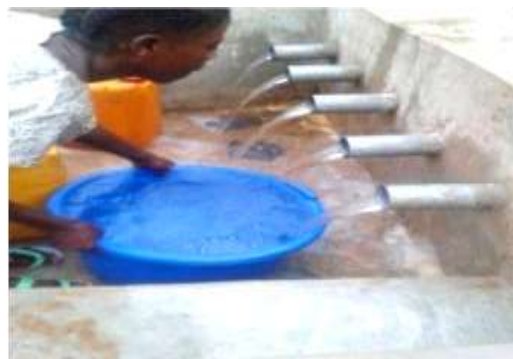
Figure 3. Il s'agit bien sûr de la source KABUSAMBU la plus productive de la zone de santé de mutoto/aire de santé de MBONDO avec un débit incontournable d'au moins 228 litre d'eau/minute, la plus propre et potable servant 1200 habitants mais aussi les villages voisins.
